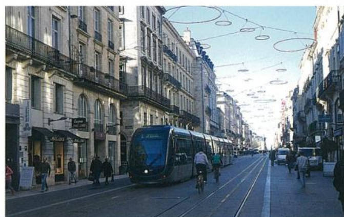
2 トラムとまちなみが一体化し、歩きやすくなるみちとなる(ボルドーのトラム区間)
